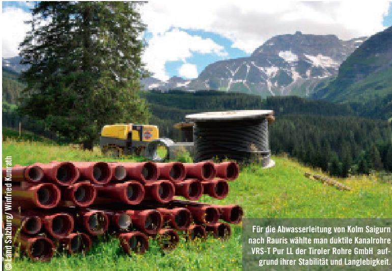
Für die Abwasserleitung von Kolm Saigurn nach Rauris wählte man duktile Kanalrohre VRS-T Pur LL der Tiroler Rohre GmbH aufgrund ihrer Stabilität und Langlebigkeit.
