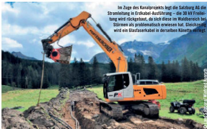
Im Zuge des Kanalprojekts legt die Salzburg AG die Stromleitung in Erdkabel-Ausführung – die 30 kV Freileitung wird rückgebaut, da sich diese im Waldbereich bei Stürmen als problematisch erwiesen hat. Gleichzeitig wird ein Glasfaserkabel in derselben Künette verlegt.
