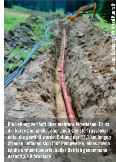
Die Leitung verläuft über mehrere Almwiesen: Es ist die kürzestmögliche, aber auch steilste Trassenvariante, die gewählt wurde. Entlang der 13,1 km langen Strecke befinden sich fünf Pumpwerke, eines davon ist die umfunktionierte, außer Betrieb genommene dezentrale Kläranlage.
